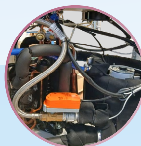
Sistema opzionale con valvola pressostatica elettronica Brevetto Fintek con algoritmo di programmazione alle varie temperature di acqua in ingresso e massimo risparmio.
